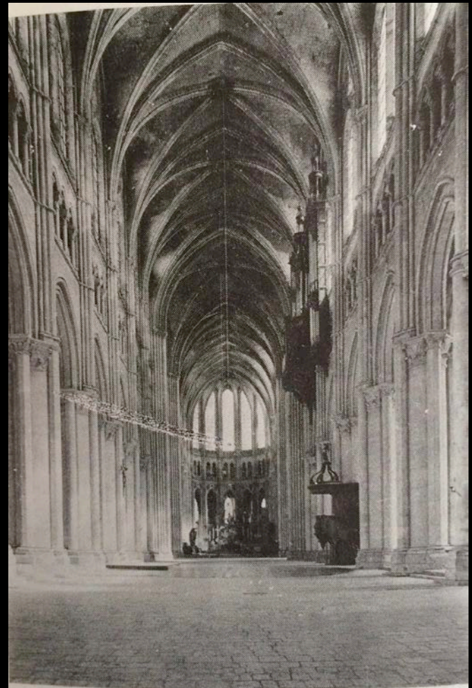
B. Interior looking E.
