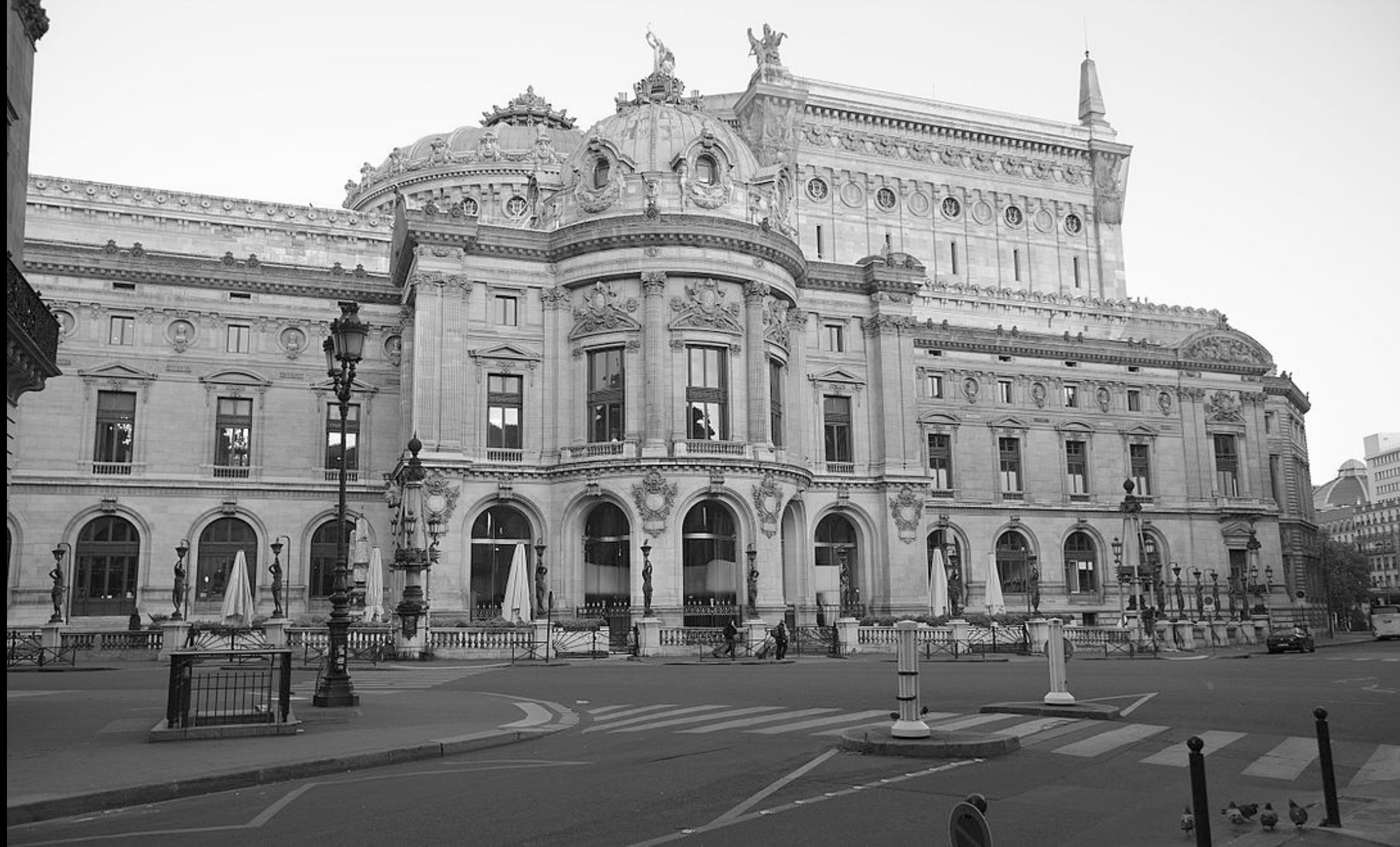
East façade; Pavillon des Abonnés
